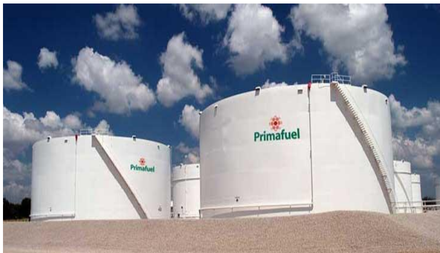
Рисунок 2. - Резервуарный парк ТОО «Кокшетауская топливная база» [65, 346]
